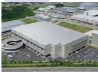
神戸市に建設中のハイブリッド型物流センター「六甲物流センター(メーカー物流)、西神物流センター(卸物流)」完成予定図
