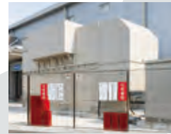
72時間物流センターを稼働できる自家発電装置を完備
